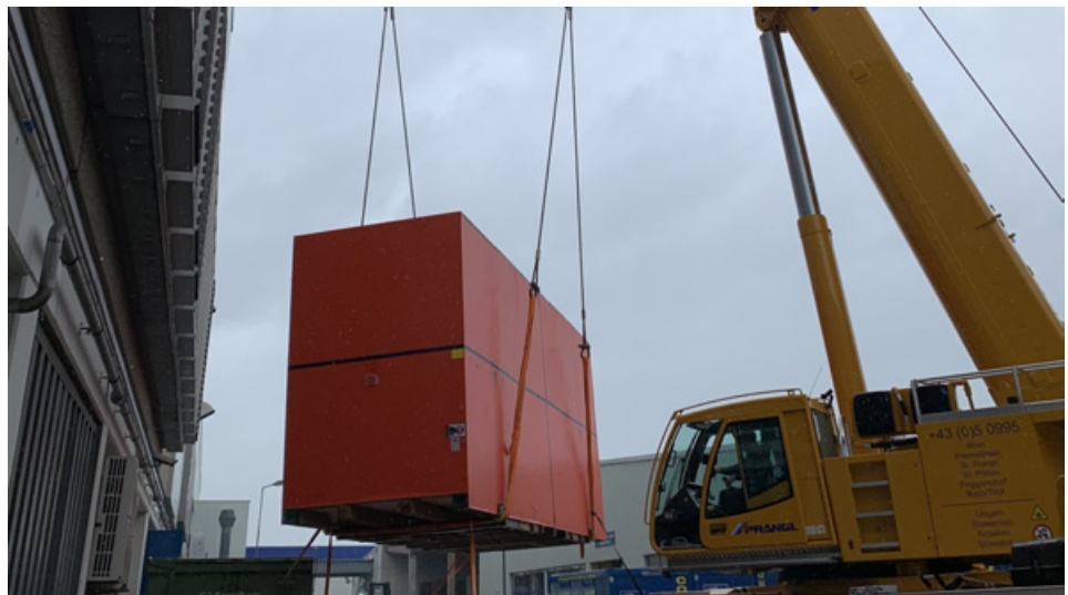
Anlieferung der neuen Produktionsmaschine
